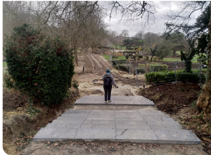
Renovatie van de trappen
