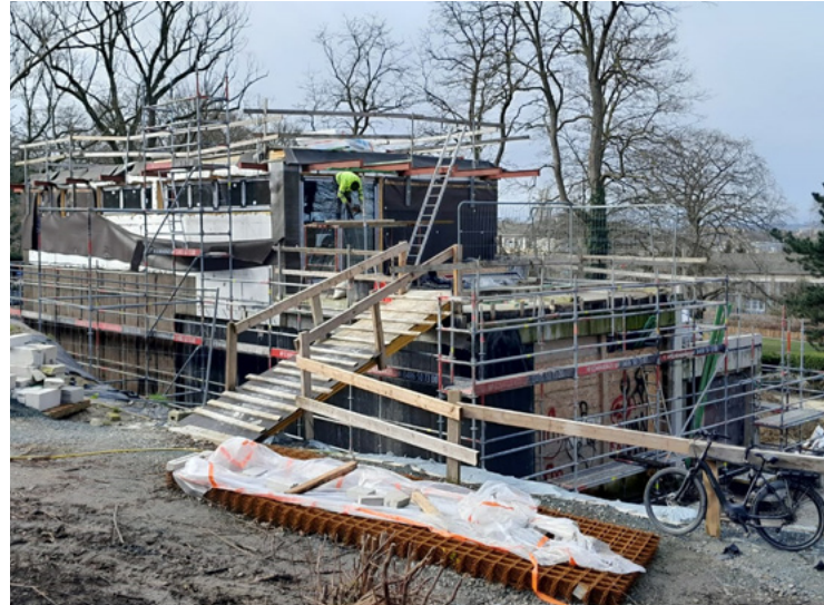
Bâtiment des jardiniers
