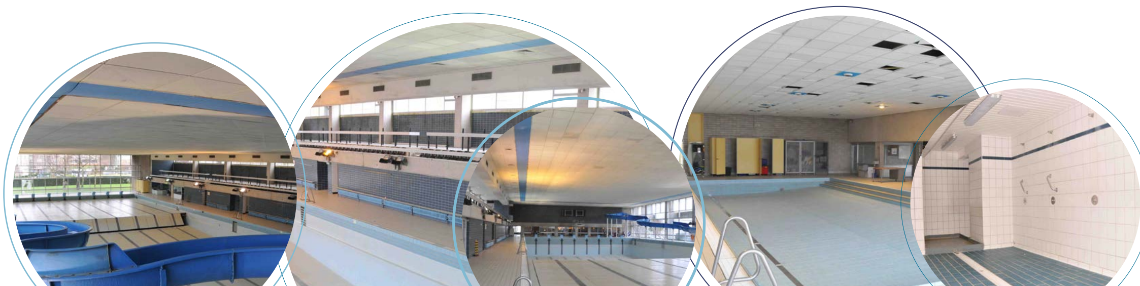
Photos de la situation existante - Foto's van de bestaande situatie
