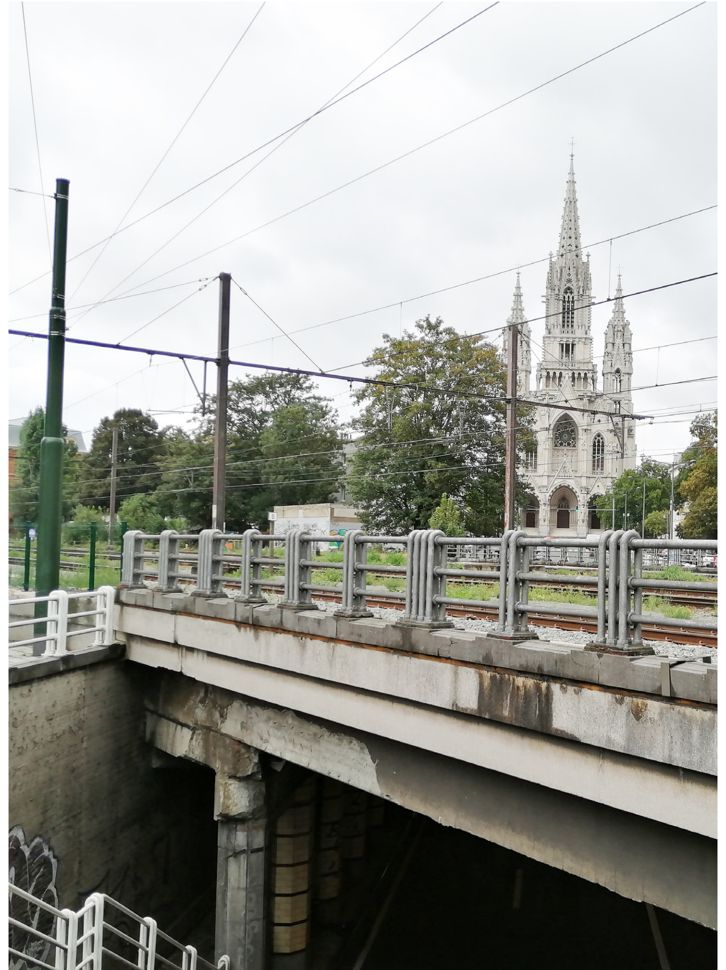
De tunnel (Koninginnelaan) onder de spoorweg
