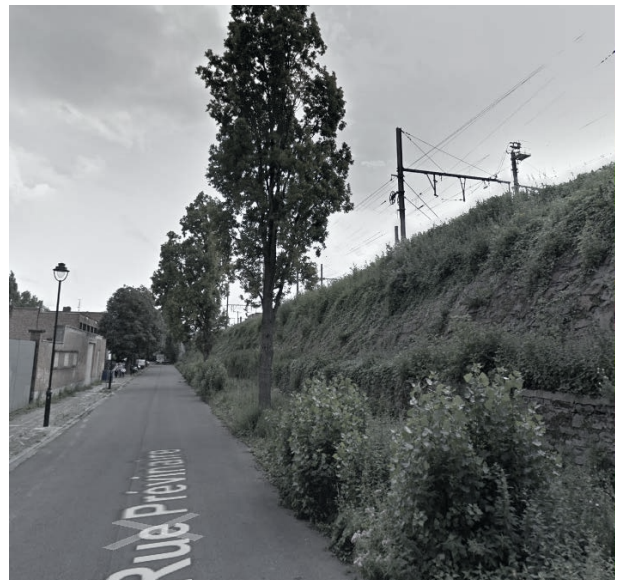
La voie ferrée
