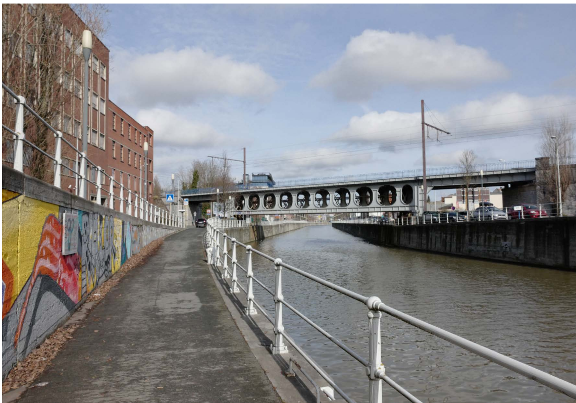
Het zicht vanuit de Fernand Demetskaai opent zich op de Vierendeelbrug van de spoorweg.
