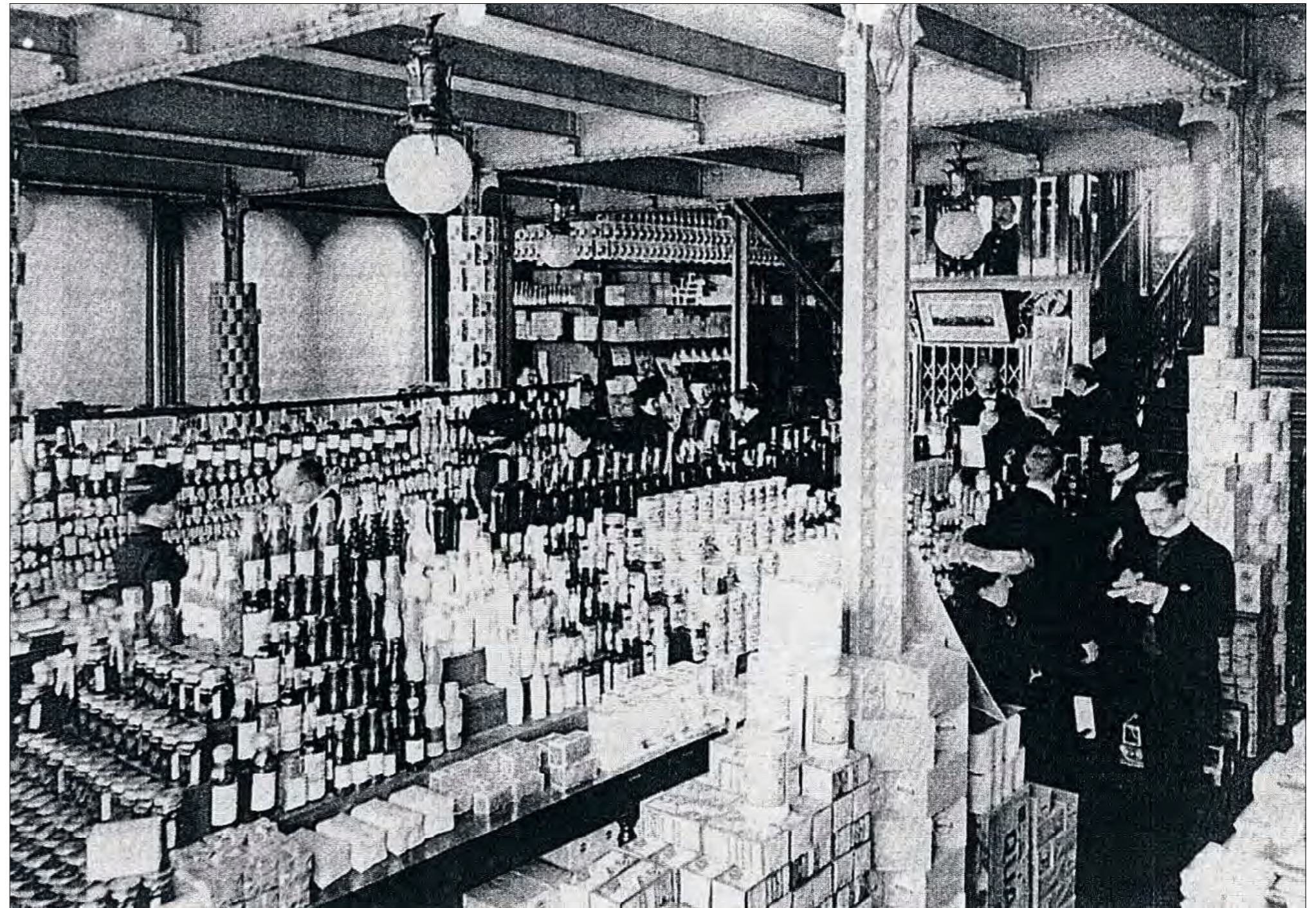
VUE INTÉRIEURE DE L'OLD ENGLAND AU 2, 3 OU 4EME ÉTAGE
