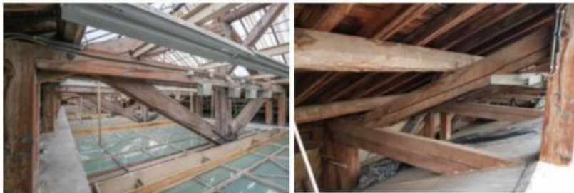
Photos de la charpente existante en bois résineux (Origin)
